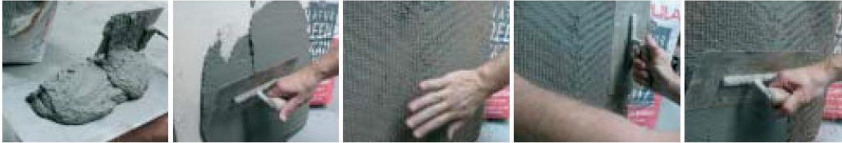
Zuerst wird Haftkleber dünn und in kleinen Mengen angerührt
