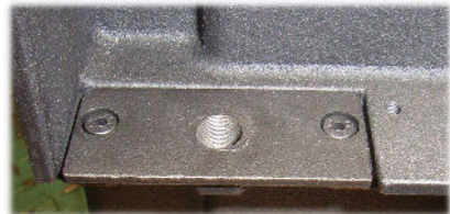
Abb. 13: Gußeinleger Türkontaktschalter
