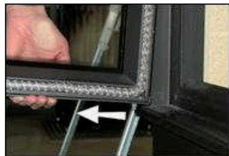
Jetzt die Tür etwas absacken lassen damit die Tür aus der oberen Führung gleitet und entnommen werden kann.
