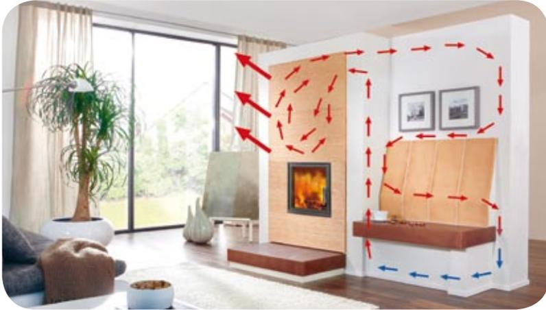
Das geht ganz einfach – denn der Warmluftmantel dieses Hypokaustensystems ist nach oben offen. So gelangt die warme Luft in die mit Speichersteinen gemauerte Schürze und erwärmt diese.
